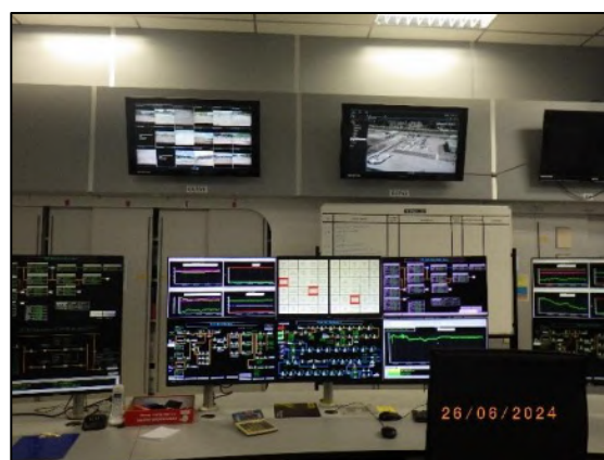
รูปที่ 2-22 การควบคุม ตรวจสอบระบบท่อส่งก๊าซฯ โดยผ่านระบบ SCADA
